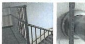
최상층 계단참 난간 기준높이 확보 (양호)
