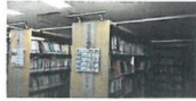
도서관 내 책장 전도방지 조치 (양호)
